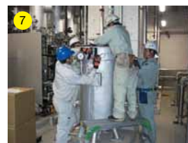
⑥工場に向いて取り付け を行う。面ファスナーで固定す るため容易に設置できる。⑦ 大型のバルブに、それに合わ せたファインジャケットを取 り付ける。大きいので、複数 人で慎重に取り付けを行う。
