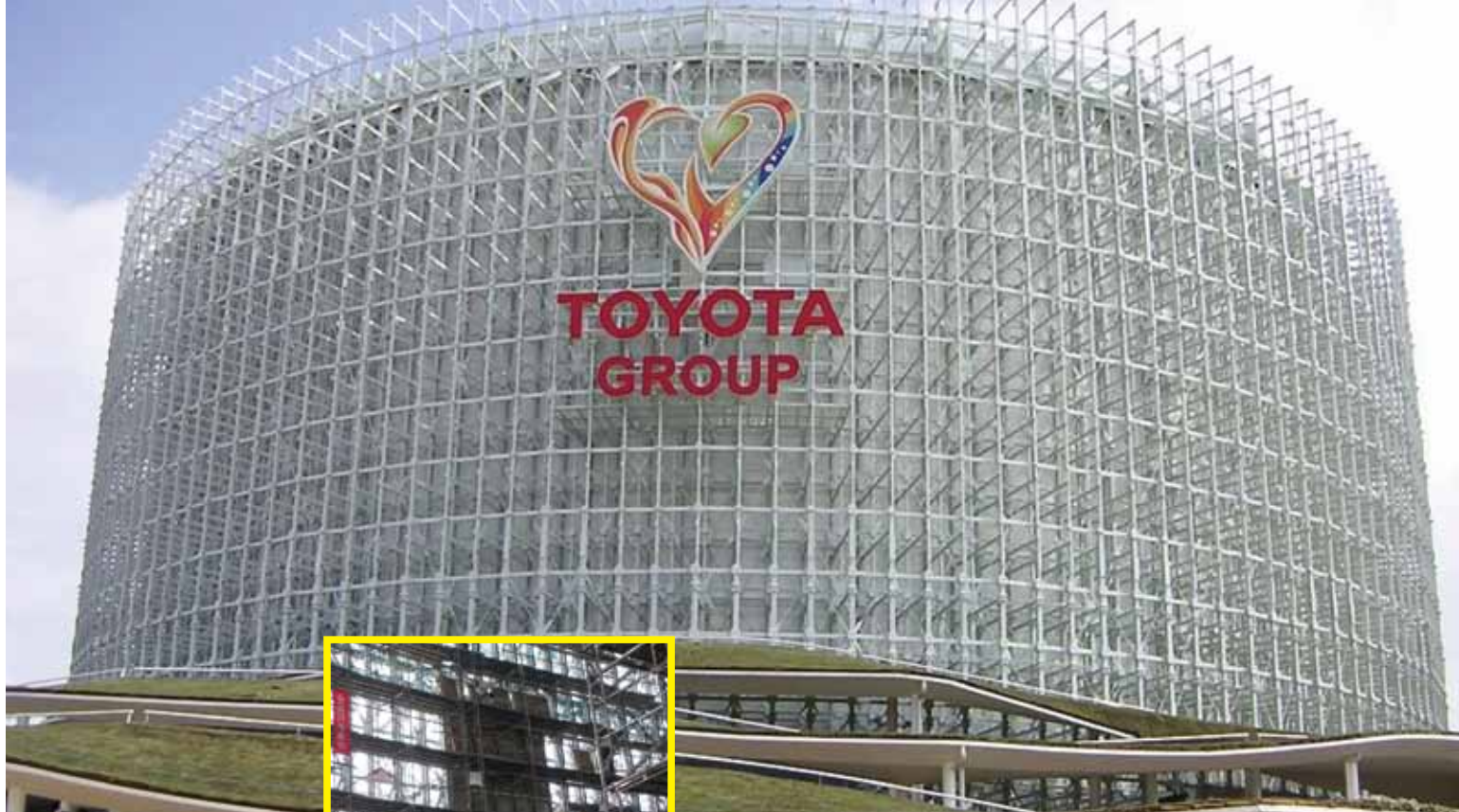
「愛・地球博」でのトヨタグループ館の全景写真。外部を囲っている軽量鉄骨の軸組みに取り付けられている白色のボードが、日本化工機材が開発した画期的な再生紙での外壁。
