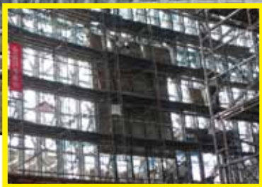
「愛・地球博」でのトヨタグループ館の全景写真。外部を囲っている軽量鉄骨の軸組みに取り付けられている白色のボードが、日本化工機材が開発した画期的な再生紙での外壁。
