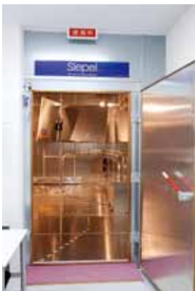
フランス製リバレーションチャンバーを日本で初めて導入。無線機器・アンテナ等の測定時間を短縮。
